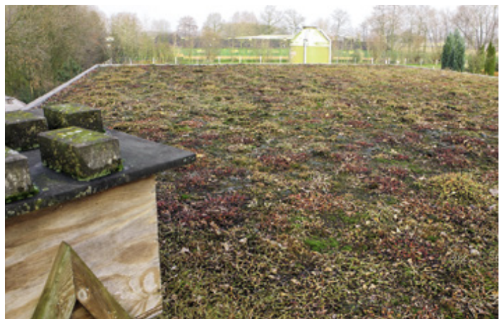
Das mit Pflanzen bedeckte Dach sorgt dafür, dass der Stall vor allem im Sommer deutlich länger kühl bleibt. Das reduziert den Hitzestress.
